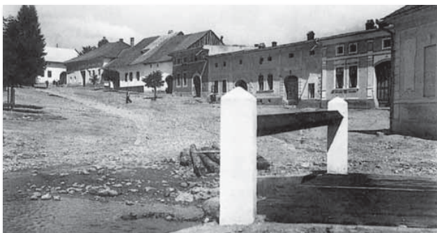
Der Ortsteil am Anfang der 1930er Jahre. Nach einem Hochwasser wurde die Brücke erneuert, rechts ist noch die Ecke der Volksschule zu sehen...
